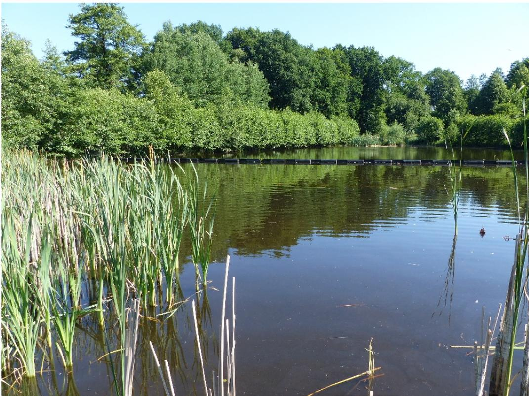
**Abbildung 42: Einlaufbecken mit Ölsperre (Wasserfläche ca. 85m x 35m), mit Rohrkolbenröhricht im Übergang zur Wurzelklärstrecke (Blickrichtung Nord)**
