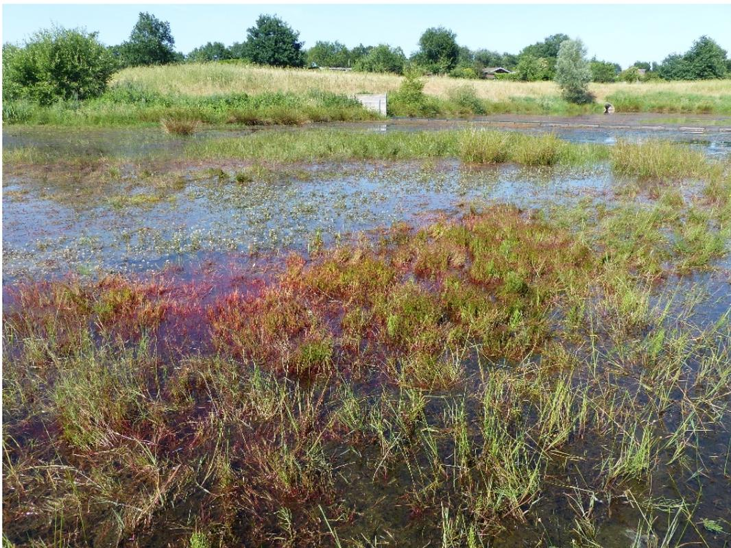
**Abbildung 60:** Die Wurzelklärstrecke hat im Osten eine ausgedehnte Flachwasser- bzw. Überstauungszone mit vielfältiger Feuchtvegetation, weiter im Westen ist sie mit Hochstaudenröhricht bestanden (hier der östliche Bereich, Blick nach Nordosten).
